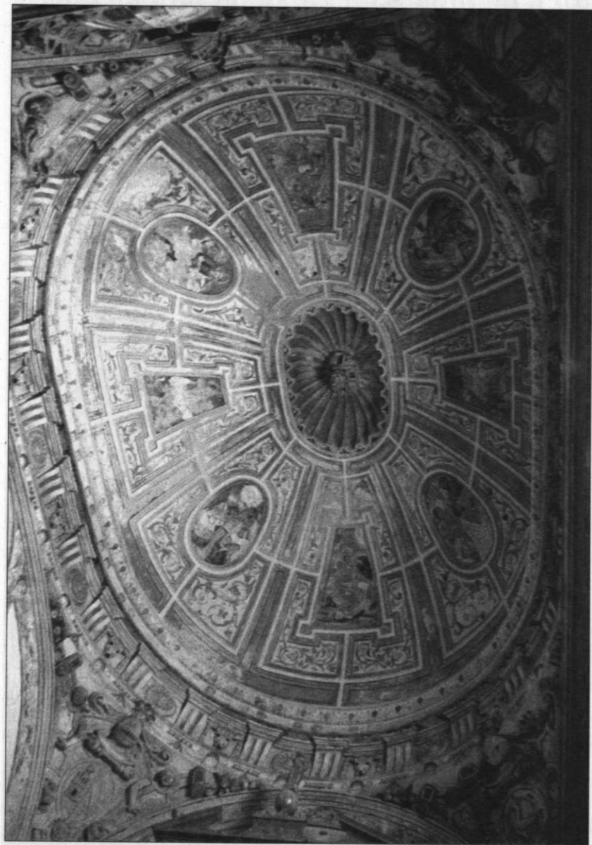
1. Arcicóllar (Toledo), Capilla Villaseca, bóveda.
